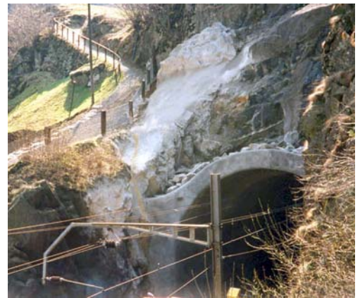
Felskopf abgetragen, Felspartie gesichert und Vortunnel aus Spritzbeton erstellt
