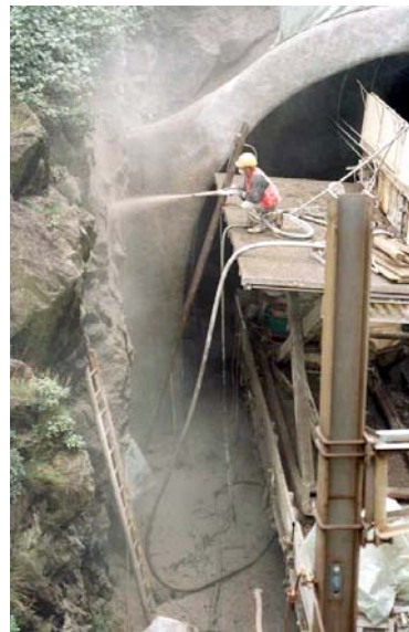
Felssicherung mit Spritzbeton zur Verhinderung von Niederbrüchen (Eis- und Steinfragmente)
