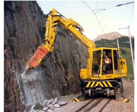
Reinigung und Abtrag einer instabilen Felswand
