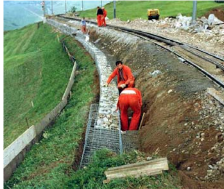
Sicherung Bahntrasse mit Steinkorbmauer
