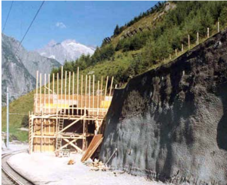
Felsvernagelung und Spritzbetonsicherung
