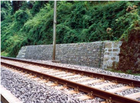
Instandsetzung Stützmauer durch Teilersatz mit Steinkörben
