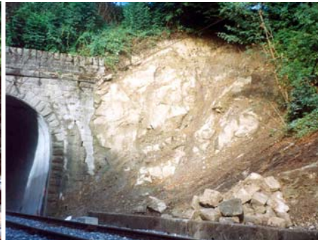
Gereinigte Felspartie beim Ostportal des Schwarzenbachtunnels
