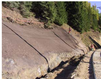
Hangsicherung mit Seilankern und Auftrag einer stabilisierenden Vegetationsschicht
