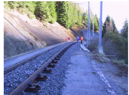
Hangsicherung mit Felsvernagelung, Netzabdeckung und Vegetationsschicht
