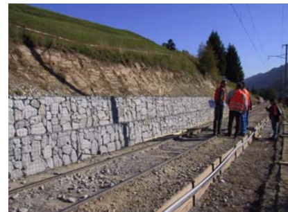
Böschungssicherung mit Steinkorbmauern
