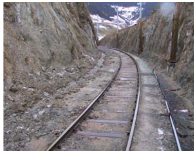
Abtrag und Reinigung Felseinschnitt vor Montage der Netzabdeckung
