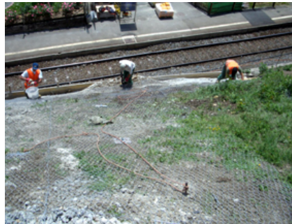
Verlegen der Maschendrahtnetze
