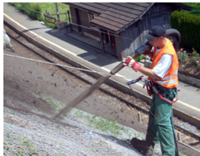
Aufspritzen der Vegetationsdecke (Fibrater)
