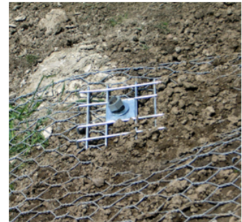
Ankerkopf mit Krallplatte (Felsvernagelung)
