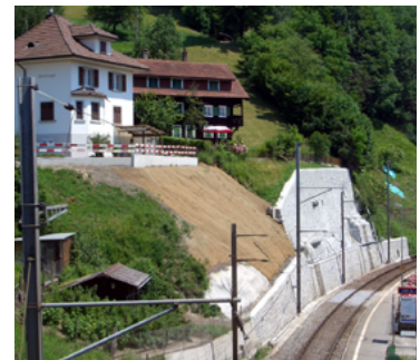
Fertig erstellte Hangsicherung
