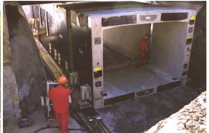
Einbau der vorfabrizierten PU-Elemente
