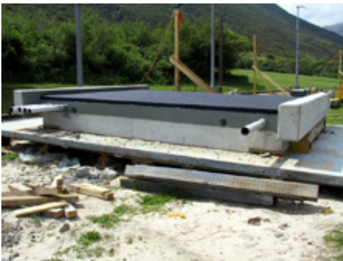
Neue Brückenplatte fertig vorbereitet
