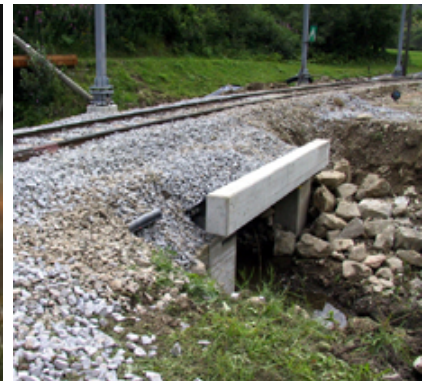
Neue Brücke «am Tag danach»
