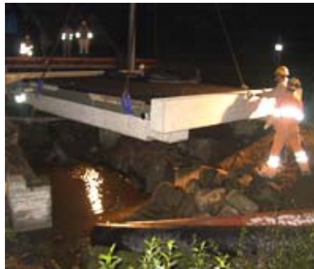
Einbau der neuen Brückenplatte
