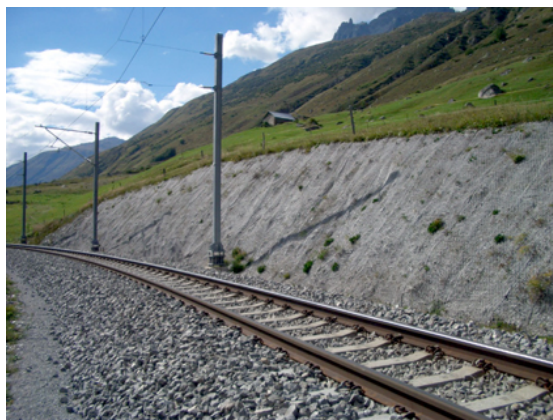
Hangsicherung mit Felsvernagelung, Netzabdeckung und Vegetationsschicht
