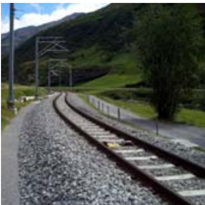
Unter- und Oberbauerneuerung
