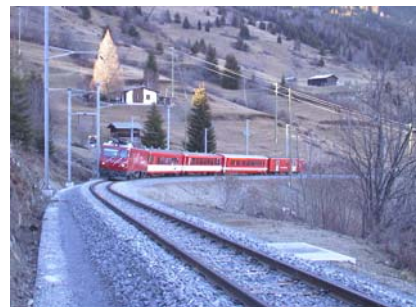
Neues Trasse, Fahrleitung, Kabelanlage, Entwässerung
