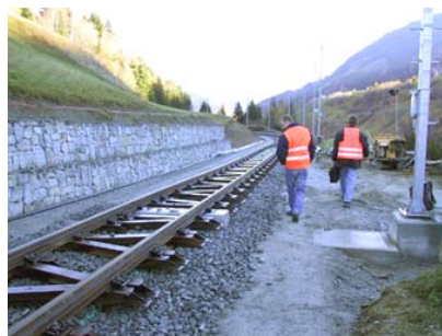
Böschungssicherung mit Steinkorbmauern, Einbau Y-Schwellen, Signalanlage
