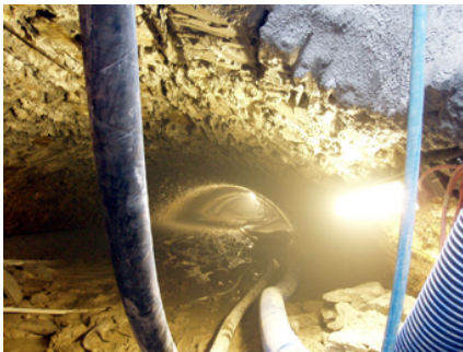
Fabrikkanal mit Installationen bei Arbeitsbeginn
