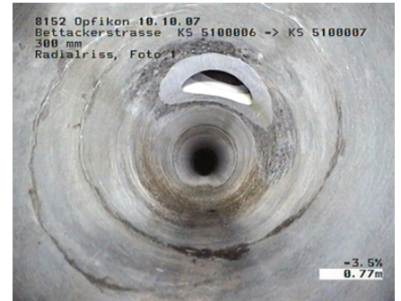
Instand gesetzter seitlicher Anschluss mit Kanalroboter-Verfahren. Im Vordergrund: noch nicht instandgesetzter Radialriss.
