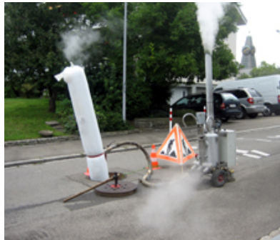
Endschacht bei Schlauchrelining-Verfahren DN 300 mm mit Dampfaushärtung.
