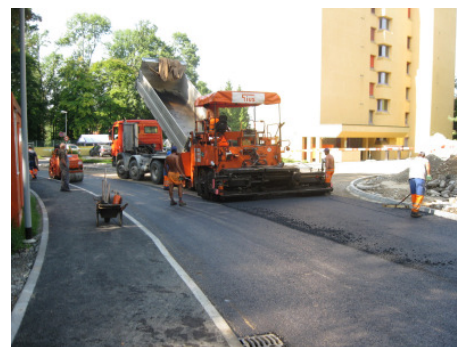
Einbau Tragschicht
