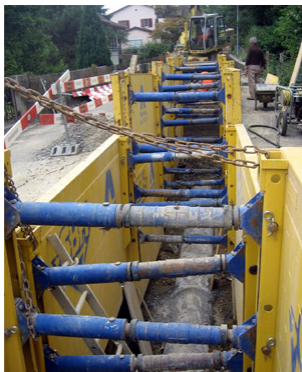
Kanalisation Rebhaldenstrasse Centub Betonrohre DN 600 mm.
