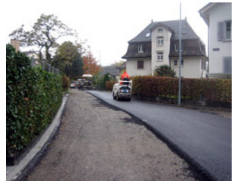
Einbau bituminöse Tragschicht bei der Zelgstrasse.
