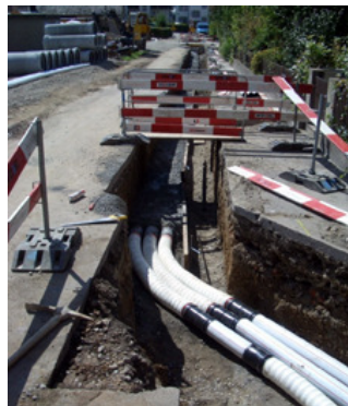
Werkleitungen Zelgstrasse, Kombigraben EW / Wasser.
