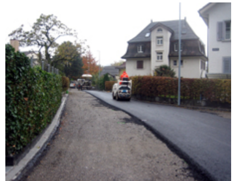
Einbau bituminöse Tragschicht bei der Zelgstrasse.
