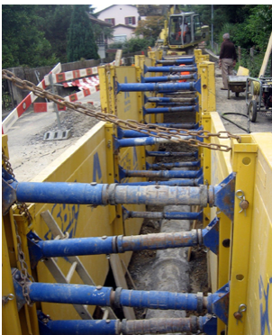
Kanalisation Rebhaldenstrasse Centub Betonrohre DN 600 mm.
