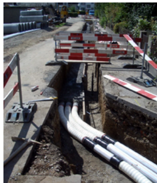
Werkleitungen Zelgstrasse, Kombigraben EW / Wasser.
