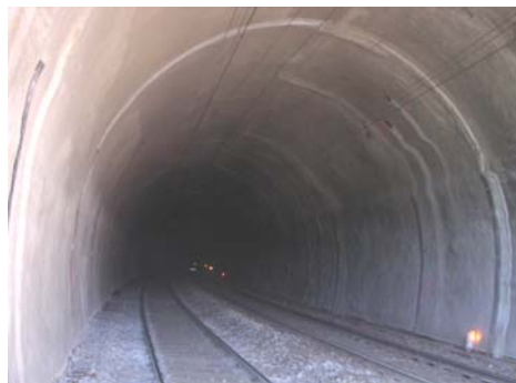
Gewölbeverkleidung mit Spritzbeton
