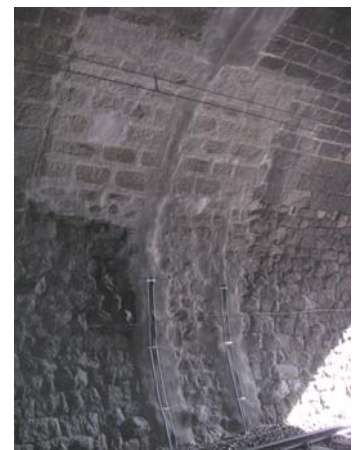
Drainagen und Fugensanierung
