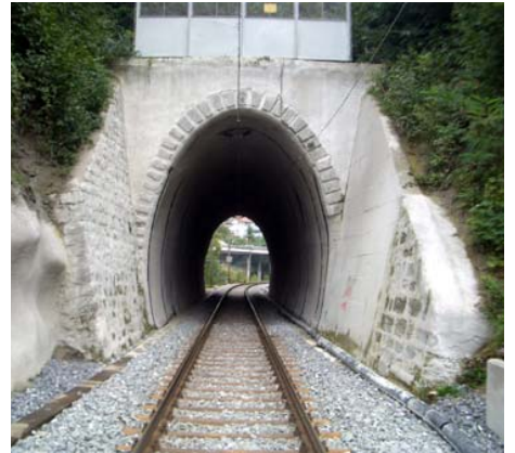
Fertig erneuerter Tunnel nach dem Umbauwochenende
