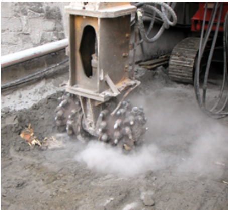
Abtrag der Felssohle mit Teilschnittfräse
