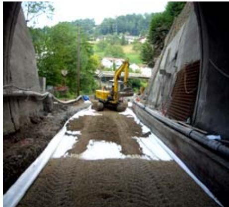
Einbau Vlies, Splitt, Vlies, Planumsschutzschicht (PSS)
